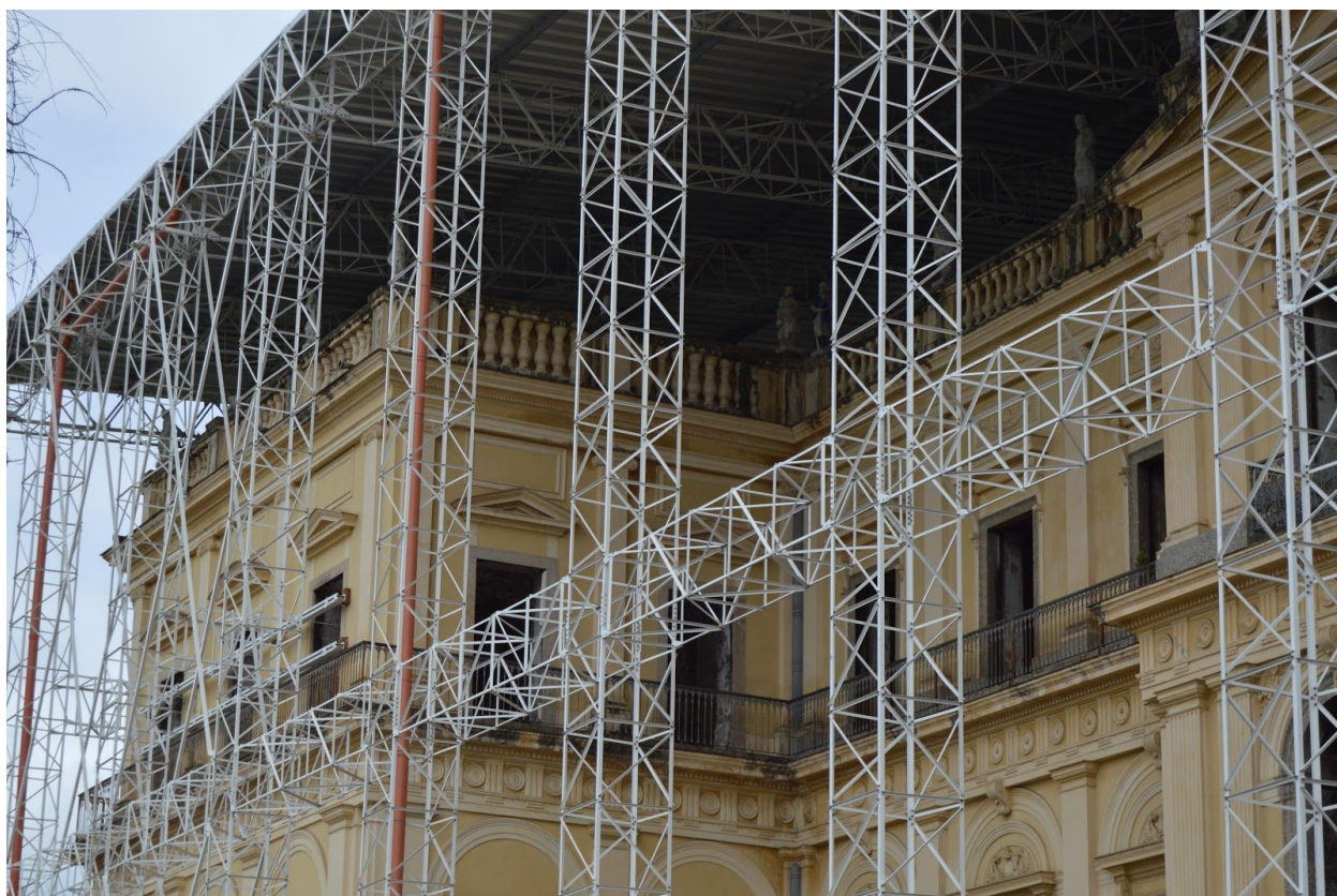
Museu Nacional em reforma depois do incêndio de 2018. Foto: Luciana Cavalcanti
